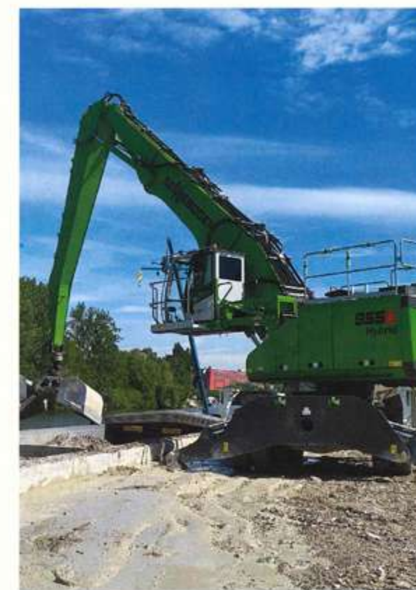
Pelle Sennebogen 855 E au déchargement d'une péniche avec des inertes de classe 3.
