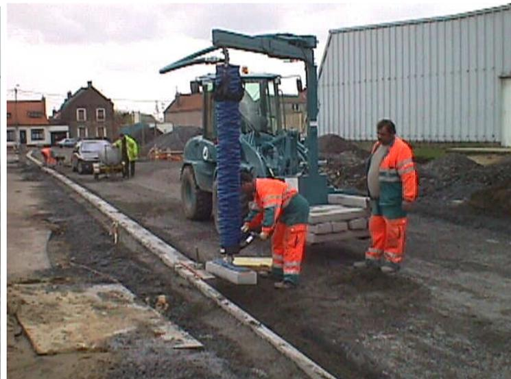
Le TURBOPOSE s'installe sur les fourches d'un chariot élévateur
